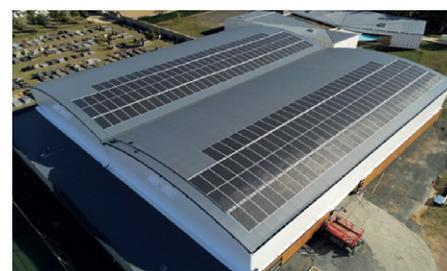
Modules souples installables sur les toitures non-planes
